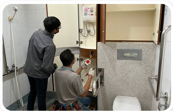
▲ 廁所汰換施工時
