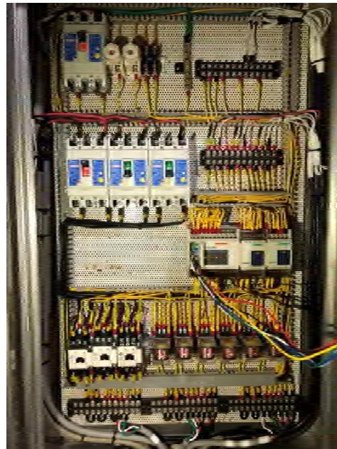
圖 14 溫室控制箱各環控設備線上功能
