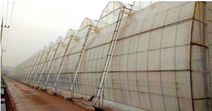
Udemji 智慧農場的溫室使用先進之環控設施，種植上採用離土栽培及根溫控制，溫室側邊則採用雙層包覆，以強化溫室之節能效果。
