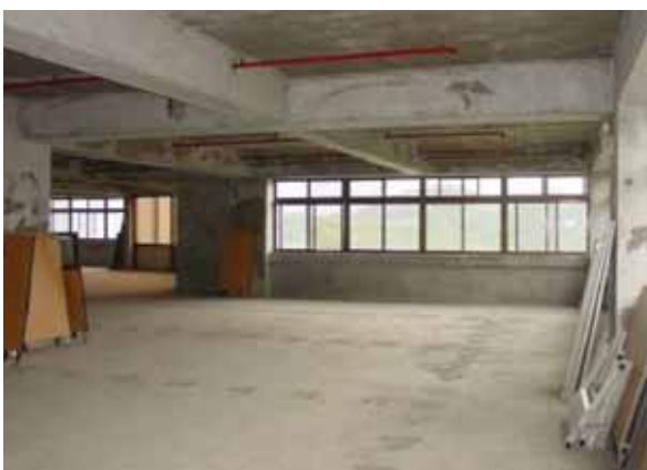
施工前之毛胚屋情形
