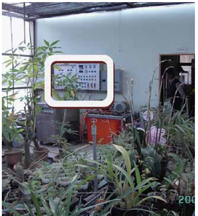
安裝於棚架溫室內之環控箱進行實地現場運轉測試
