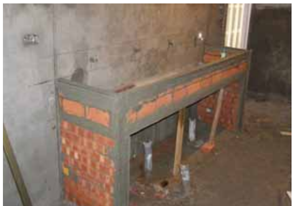
修繕工程進行中情形
