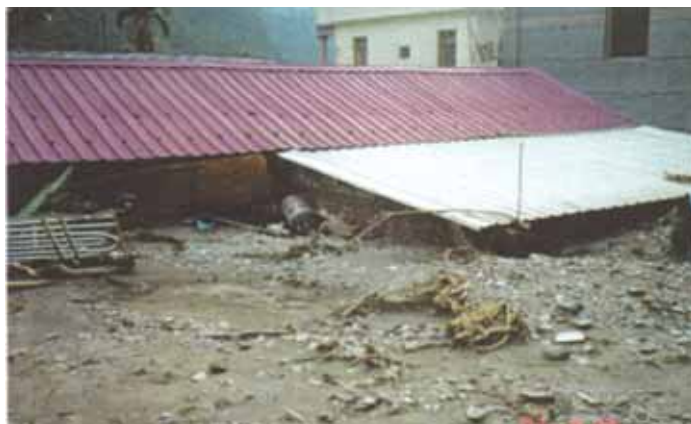
土石流侵蝕部落住屋受損現場照
