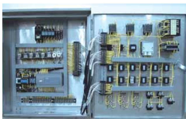
圖4 半開放式棚架溫室之模組化環控箱之內部實體配置。
