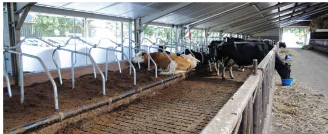
水泥鏤空條狀地面，讓糞尿可以直接至畜舍下方的貯存槽，不會造成地面濕滑，引起腳蹄問題。
