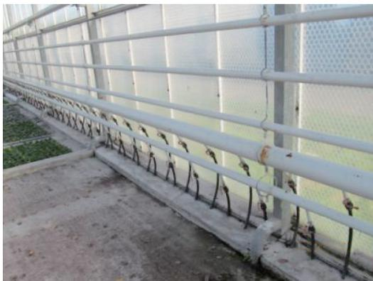
圖1 Kwekerij Piet Vijverberg溫室側牆除了用來加溫的熱水管線外，亦覆有塑膠泡泡紙以達到保溫效果。
