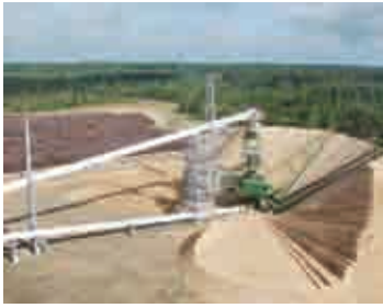
圖 7. 北側木屑片儲存場
