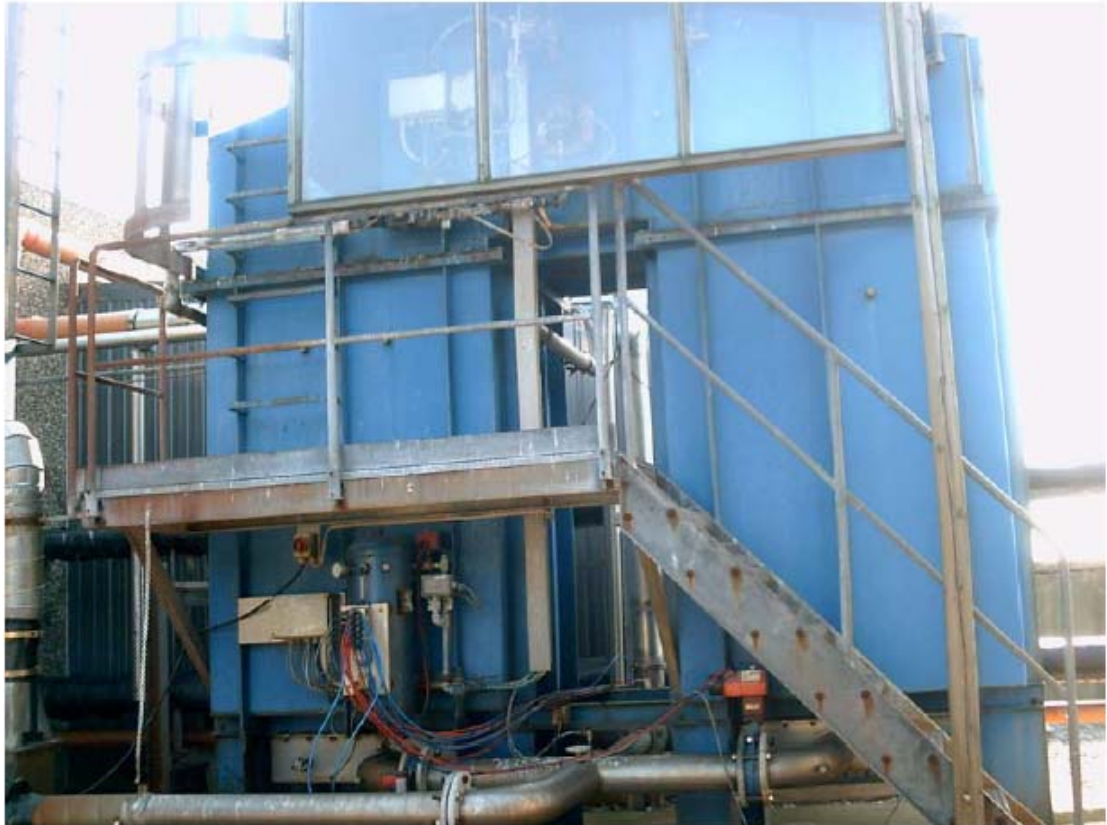
LinkoGas 沼氣廠內回收糞泥消化所產生之臭氣的燃燒處理設施外觀
