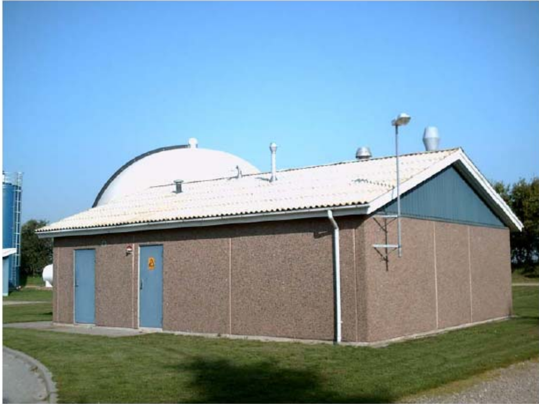
Ribe 沼氣廠內沼氣低壓輸送系統控制室外觀
