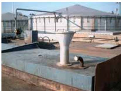
Ribe 沼氣廠內糞泥等原料之卡車注入口（前）及儲存槽（加蓋之槽體）
