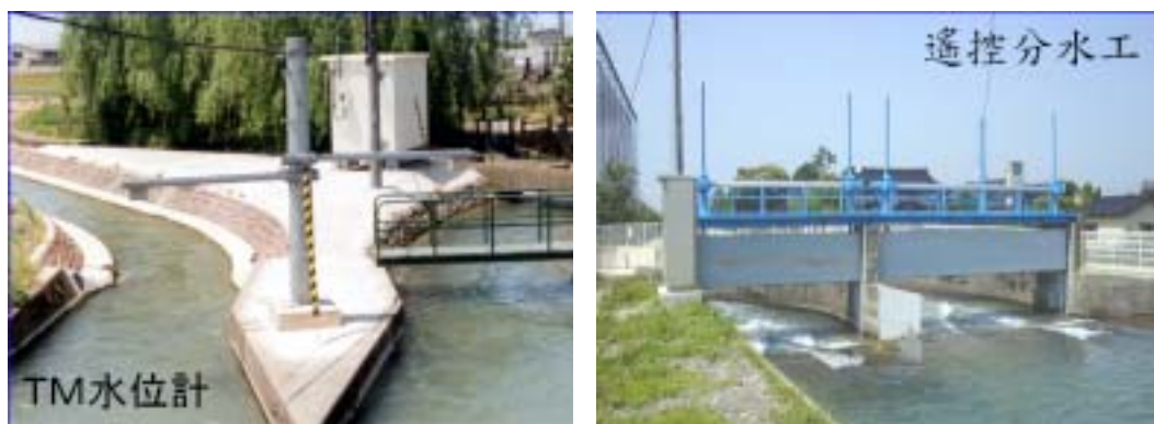
圖 6. 超音波水位計與遙控分水工
